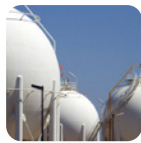
Grandes Tanques y Depósitos
